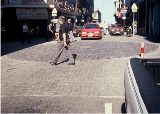
**c. Elevação da rua.** Em ruas com pouca circulação de veículos, pode-se eliminar o uso de rampas de pedestres elevando-se o nível da rua até o da calçada, o que gera rampas veiculares. Nestes casos será o veículo que ascende e desce no cruzamento e uma pavimentação tátil de alerta deverá ser colocada na calçada, sinalizando o início e término da circulação compartilhada com os veículos.
