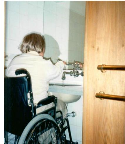
**p. barras de apoio** Dispor de barra de apoio firme na lateral da pia e do bidê, do lado oposto ao espaço livre de aproximação, com altura entre 0,70 m e 0,75 m, medidos desde o piso, que permitam que uma pessoa usuária de cadeira de rodas possa apoiar-se com força para efetuar uma transferência lateral.
